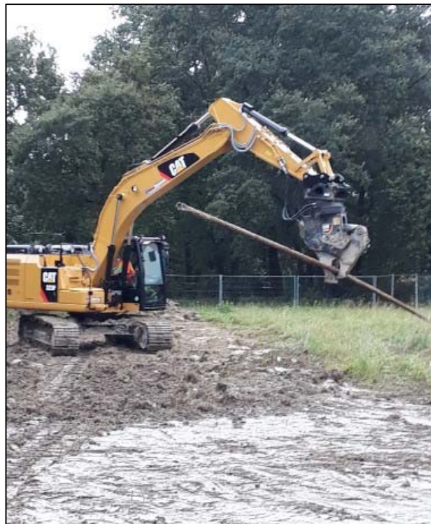
Figure 8 : Découpe de la canalisation incendie avec la pince cisaille
