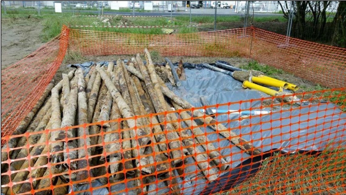
Figure 5 : Alvéole de stockage des tronçons de la canalisation découpée
