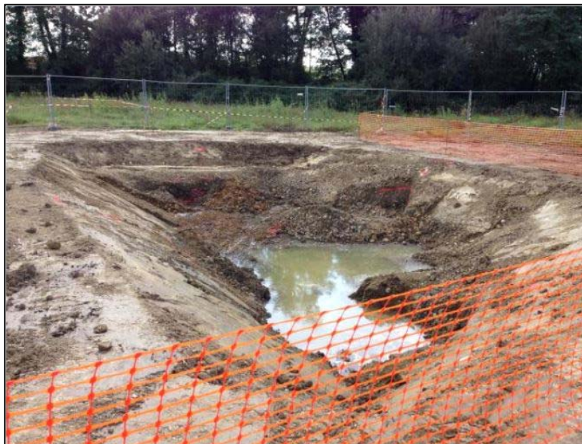
Figure 10 : Photographie de la zone polluée excavée (zone « collecteur »)
