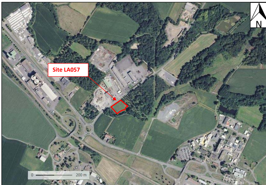
Figure 2 : Photographie aérienne du site avant travaux
