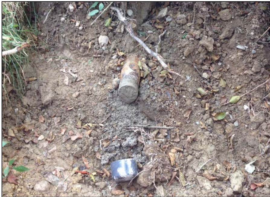
Figure 9 : Obturation de la canalisation incendie désaffectée
